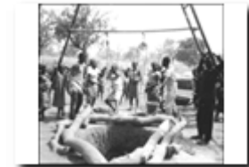
Wochenlanger Brunnenbau: wirklich gutes Wasser findet man nur in einer Tiefe von 40-50m.
